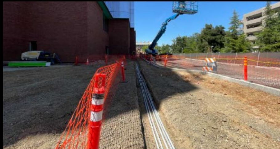
Site Lighting Conduit LLL
